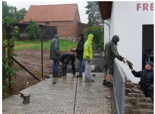
Die Pflasterarbeiten – bei jedem Wetter.
