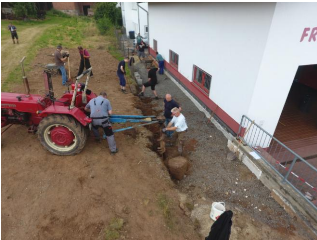
Ausschachten und Löcher für das Fundament bohren.
