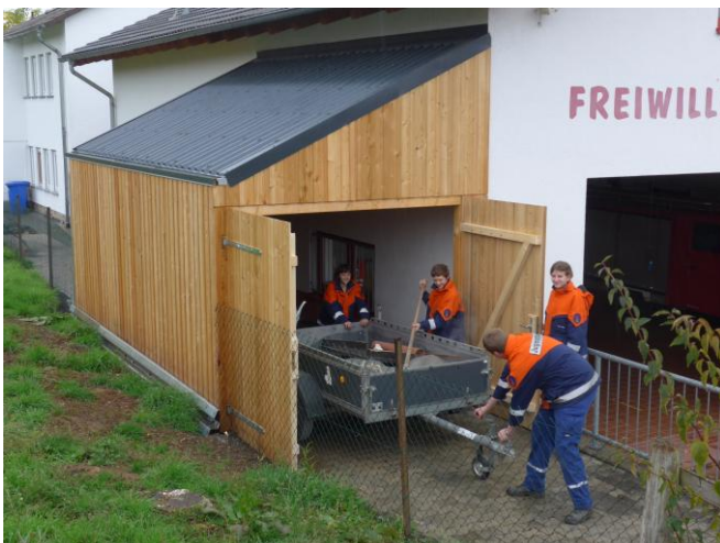
Der Materialanhänger kann zum ersten Mal in den Anbau geschoben werden.
