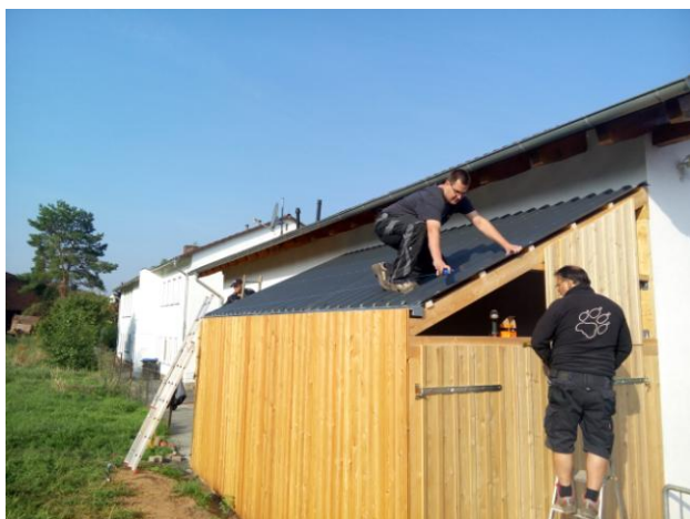
Anbau nach Tormontage. Endphase der Verschalung und Aufbringen der Dachbleche.
